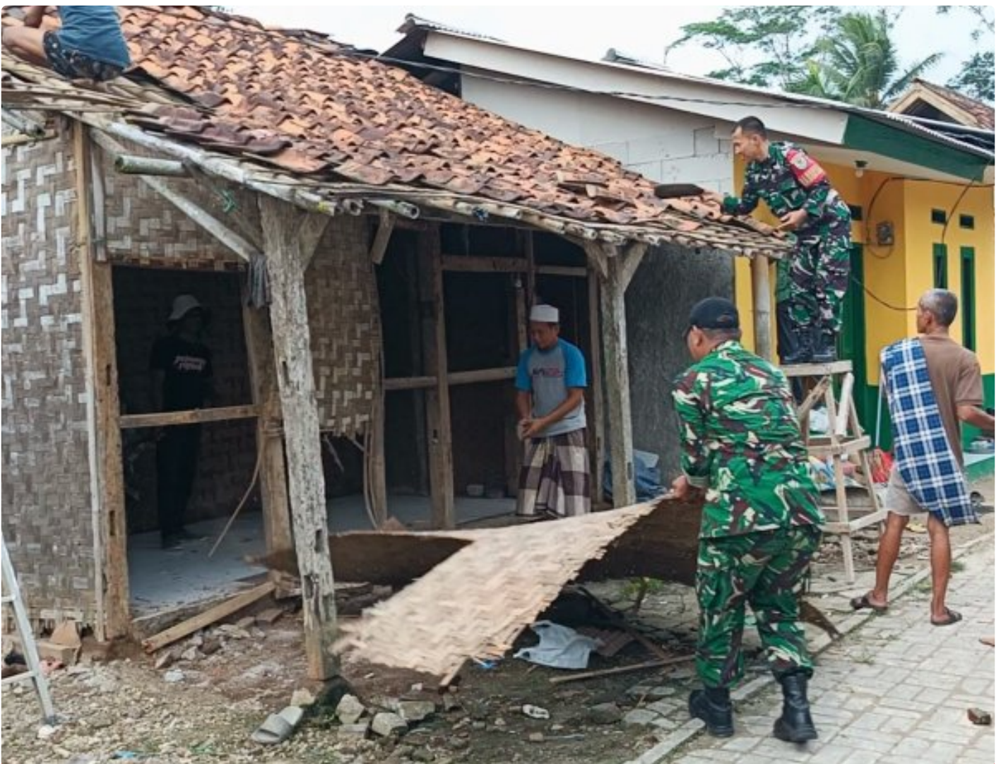
Pembongkaran Rumah Bapak Narmin
