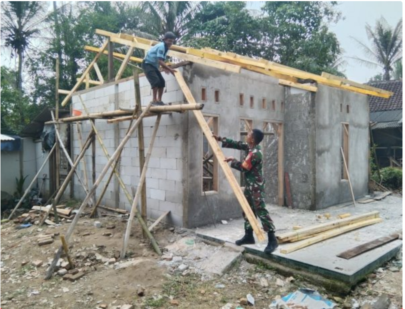
Serda Naya membantu pemasangan atap RTLH
